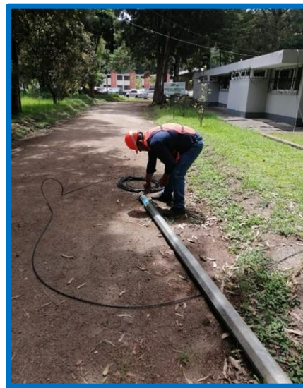
Trabajos retiro de postes zona 17.
