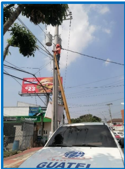
Trabajos retiro de postes zona 13.
